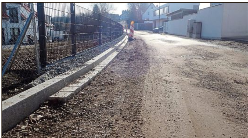
Am Vogelherd hat die Ersterschließung Ende 2018 mit dem Setzen der Randsteine begonnen.
